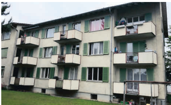
Aussenansicht vor der Kompletterneuerung der Fassade
