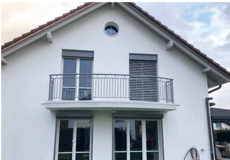
Hausfassade nach der Fassadenreparatur durch die Bürgler AG
