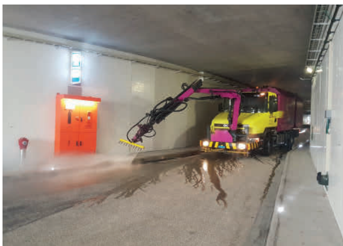
Reinigungsarbeiten im engen Bustunnel in Baden
