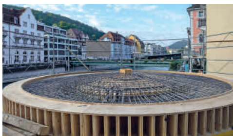
Spiral- und sternförmige Armierung
