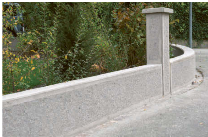
Gestockte Gartenmauer mit Pfeiler
