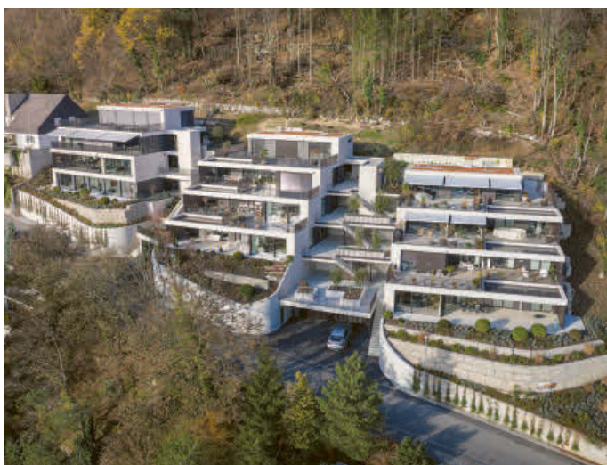
... und nach der Fertigstellung der Überbauung «La Terrasse»
