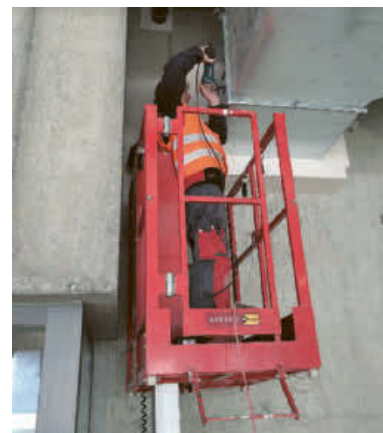
Lüftungsreinigung bei der neuen Station
