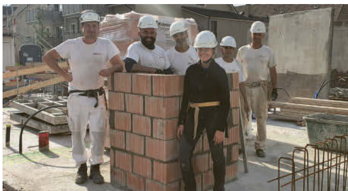
Céline Frey mit der selbst gemauerten Mauer und den hilfsbereiten Arbeitern
